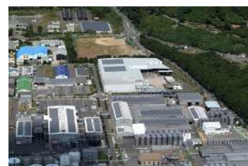
太陽光パネルを設置
