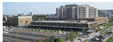
鹿児島市立病院新築空調設備工事
