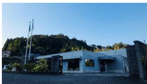
樋脇工場 外観
