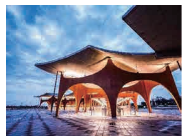
施工例: 新竹漁港観光拠点施設
