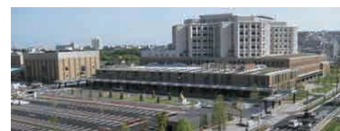
鹿児島市立病院新築空調設備工事
