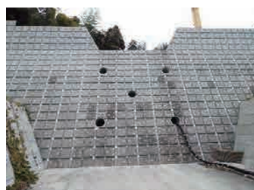
施工例；砂防ダム(緑化基盤)
