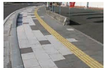
施工例；歩道(多層平板)
