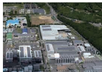
太陽光パネルを設置
