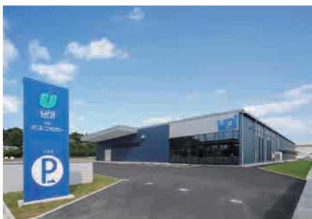
ユニカラー 本社・工場
