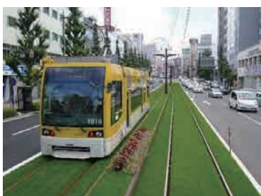
施工例；軌道敷(緑化基盤)
