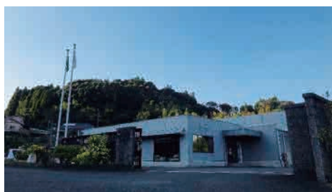
樋脇工場 外観
