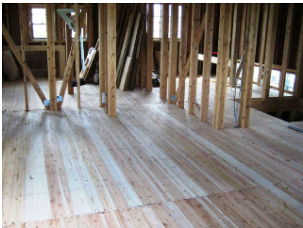
(1) 2階床構面の施工状況
