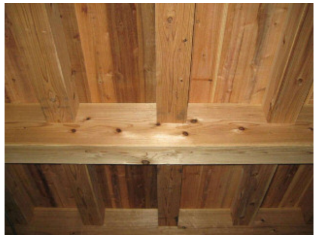
(2) 施工後に1階から見上げた状況(梁の上部が床構面)
