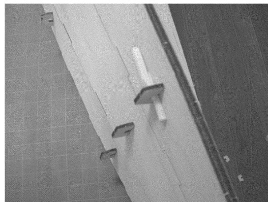
図4 隔壁と側板とのくさび固定
