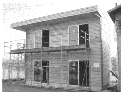
■ スギ積層材による実験用建物
