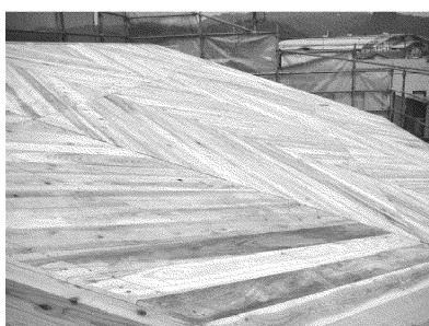
■ スギ板パネルによる屋根構面
