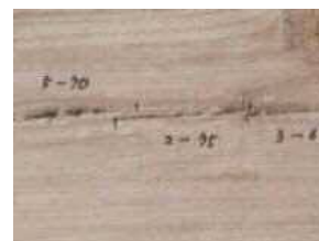
図6 平角材の表面割れ
