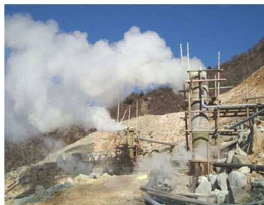
図 1 大涌谷の温泉造成塔
