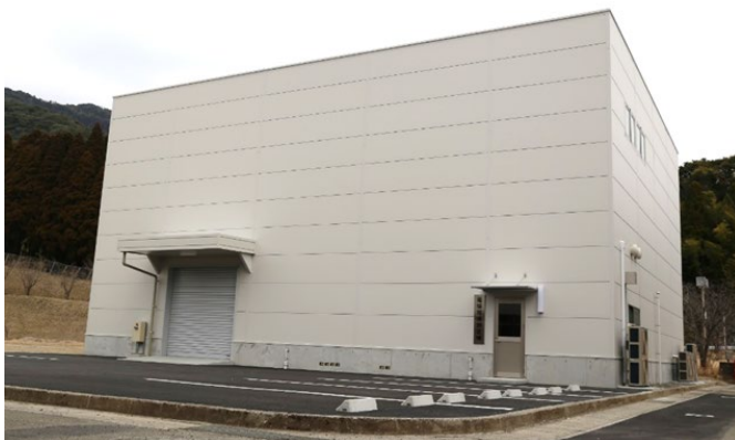
図1 電波暗室外観
