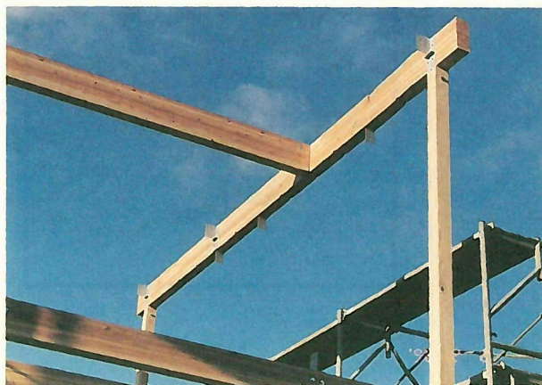
図8 軸組の組立 (B棟: 軒桁・小屋梁)
