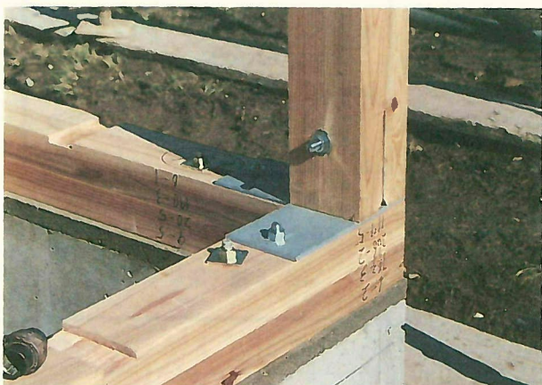
図10 通し柱-土台接合部 (B棟)
