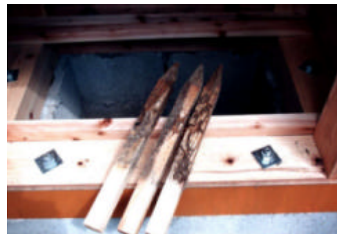
図 4 誘蟻杭の被害状況観察 (1997年 9月)
