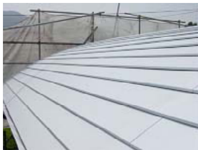
図8 シラスパルーン塗料2回目 塗装後の状態
