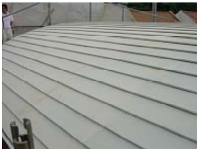
図7 シラスパルーン塗料1回目 塗装後の状態
