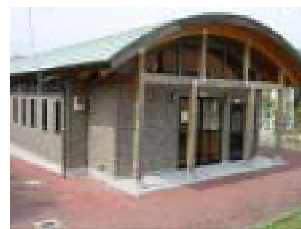
図1 現場建物南面
