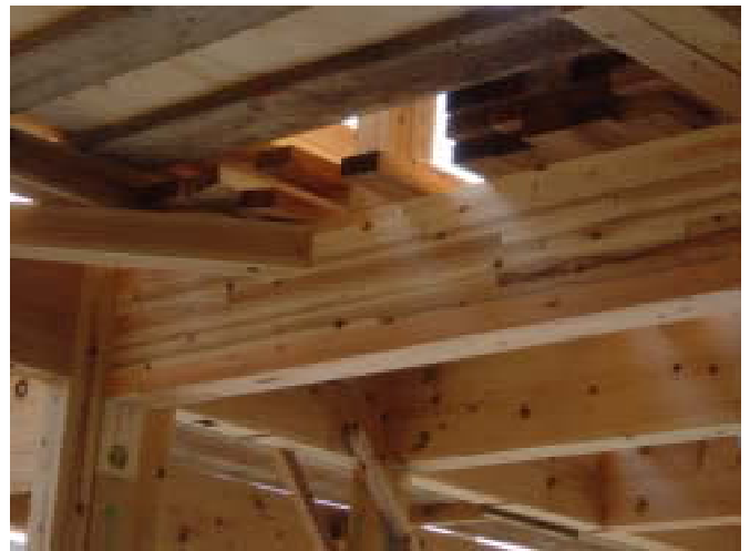
図9 異樹種集成材を利用した木造住宅の施工現場
