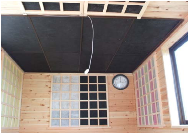
写真3 実験棟（試験区）に施工された竹炭ボード
