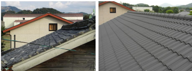
図 14 シラス瓦 リフォーム屋根工事 ユーロベスト 薩摩郡さつま町 S 邸 (左: 施工前, 右: 施工後)
