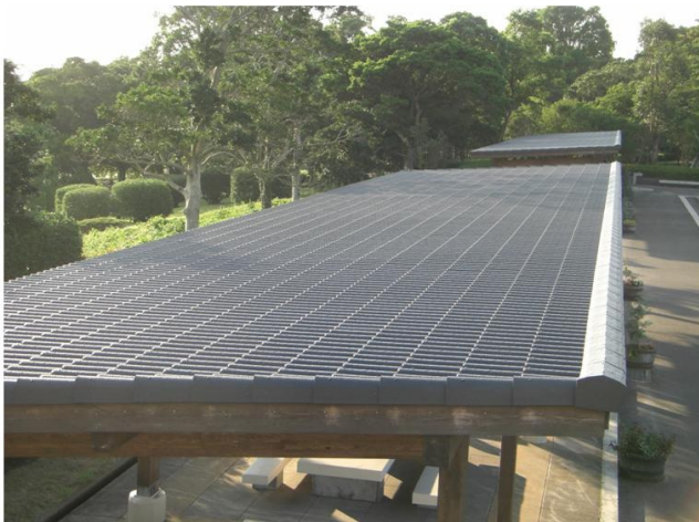
図 15 シラス瓦 新築屋根工事 ユーロベスト 鹿児島市 吉野公園
