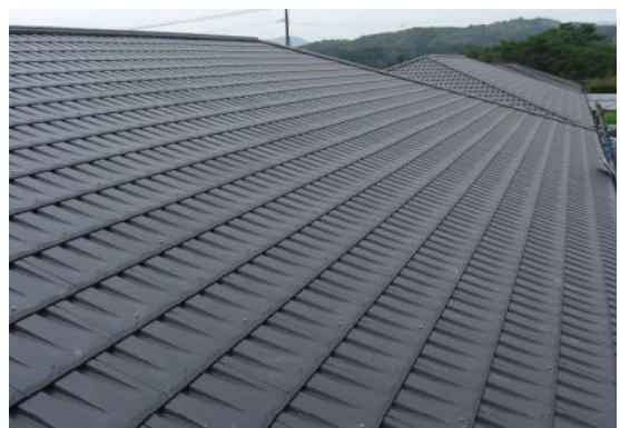
図 19 シラス瓦 新築屋根工事 石娘 S-24 薩摩郡さつま町 Z 邸
