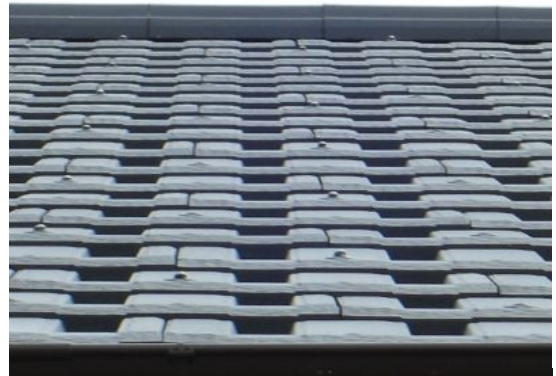
図 18 シラス瓦 新築屋根工事 石娘 S-24 薩摩郡さつま町 Z 邸
