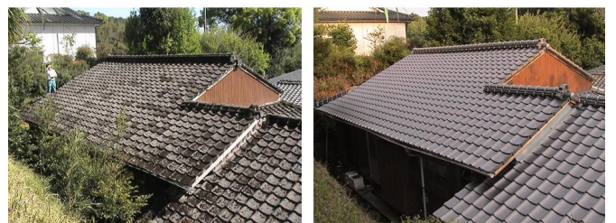
図13 シラス瓦 リフォーム屋根工事 和瓦防災タイプ 鹿児島市S邸(左:施工前, 右:施工後)
