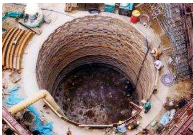
図3 温泉環境橋脚基礎へのシラスコンクリートの施工状況
