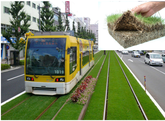
図13 軽石基盤による軌道敷緑化
