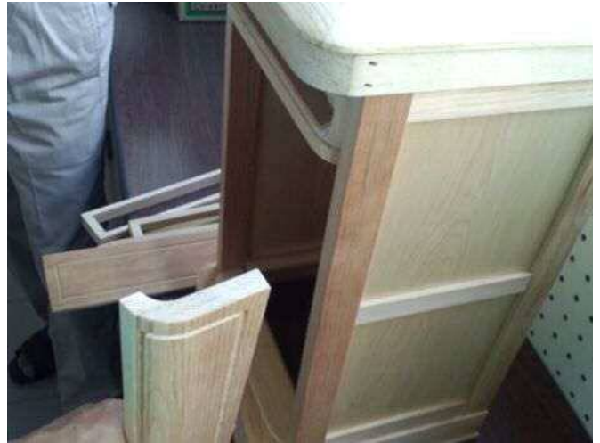
図14 曲面加工された扉
