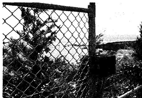
No4 フェンス(亜鉛引き) (知名町・海岸) 建設後3年
