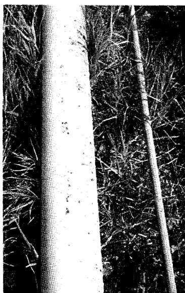
No9 燃料輸送パイプ(タール系塗装) (知名町・海岸) 敷設後3年
