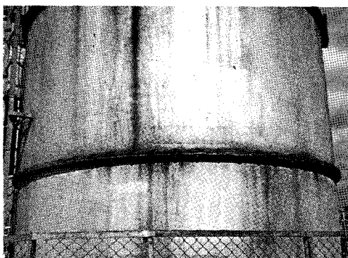
No8 燃料タンク (知名町・海岸) 建設後6年経過・再塗装(3回塗)6ヶ月
