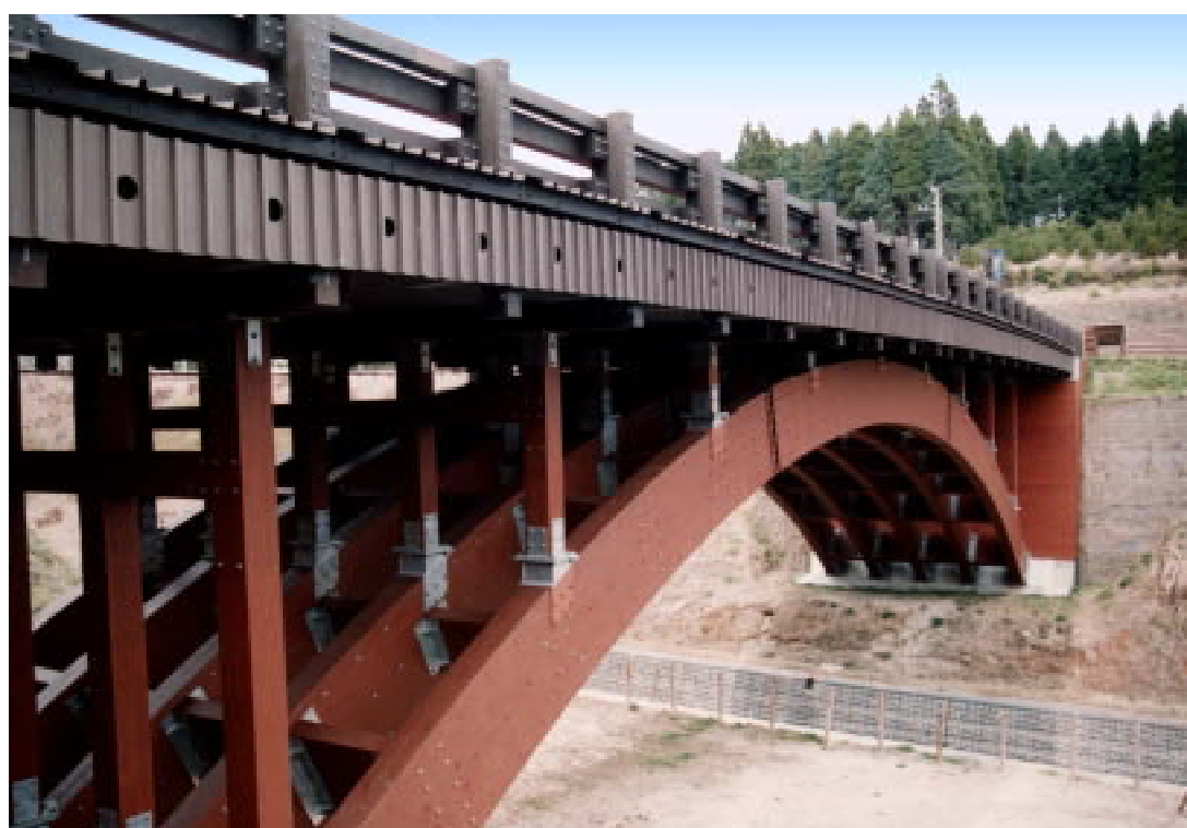
スギ集成材を用いた木橋「金峰 2000年橋」
