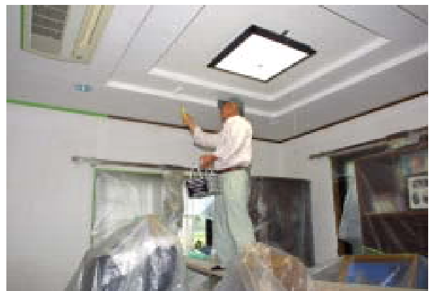
現場塗装風景
