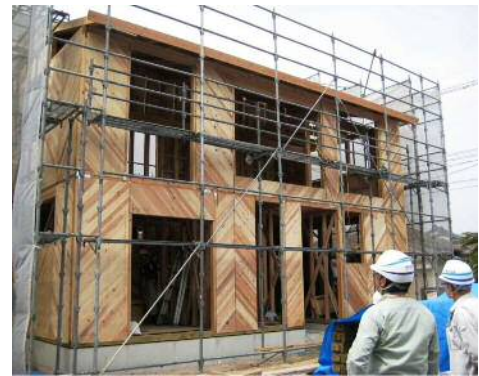
「どんとパネル」を使用した住宅の建設
