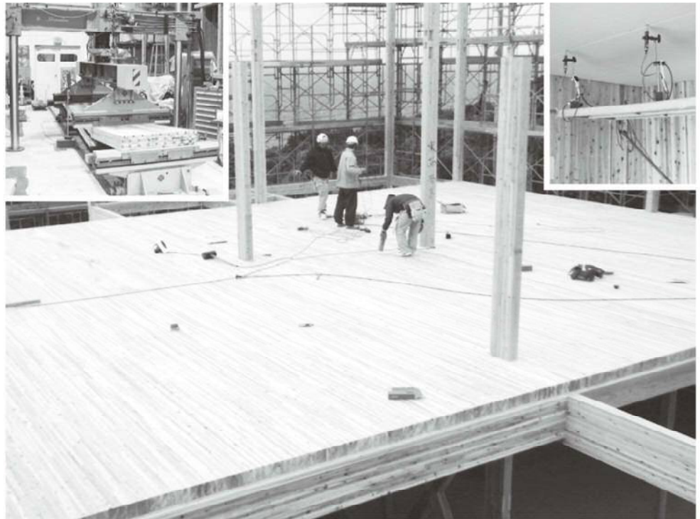
スギ積層床パネルの建築施工事例及び性能評価試験
