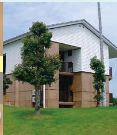
シラスバルーンペイント施工物件 折半屋根壁サイディング及びモルタル塗布
