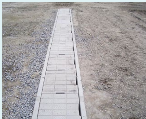
シラスコンクリート落蓋側溝施工状況
