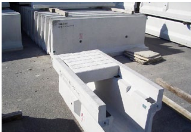
シラスコンクリート落蓋側溝セット状況
