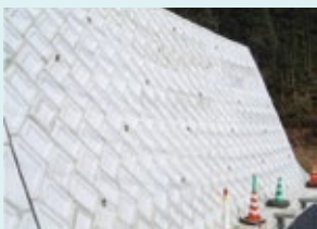
県単道路整備岸良高山線
