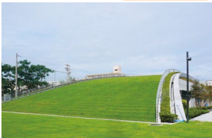
かごしま環境未来館「屋上緑化」
