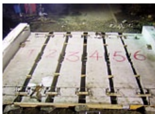
桁架設完了
