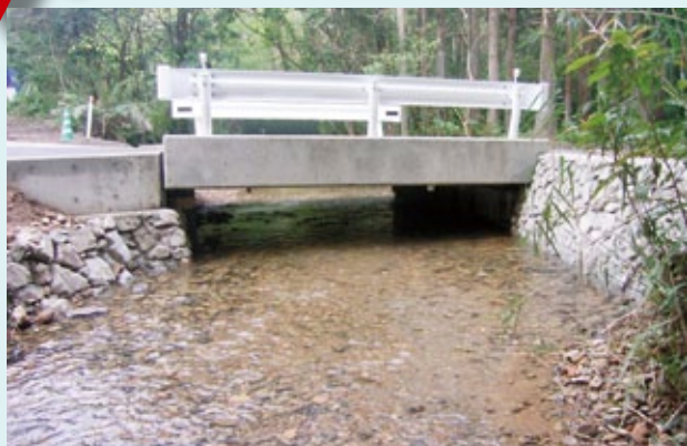
シラスコンクリートを使用した橋りょう
