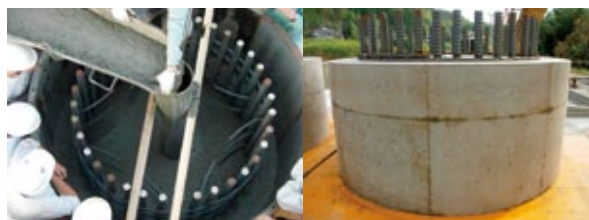
写真-6 高流動シラスコンクリートの施工実験 18)
