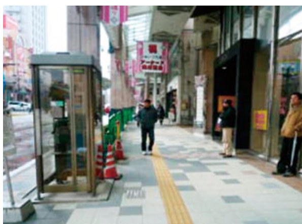
図 15 シラスブロックを敷き詰めた舗道
