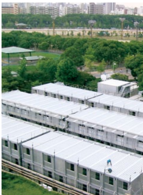
図9 シラスバルーン塗料を施工した屋根
