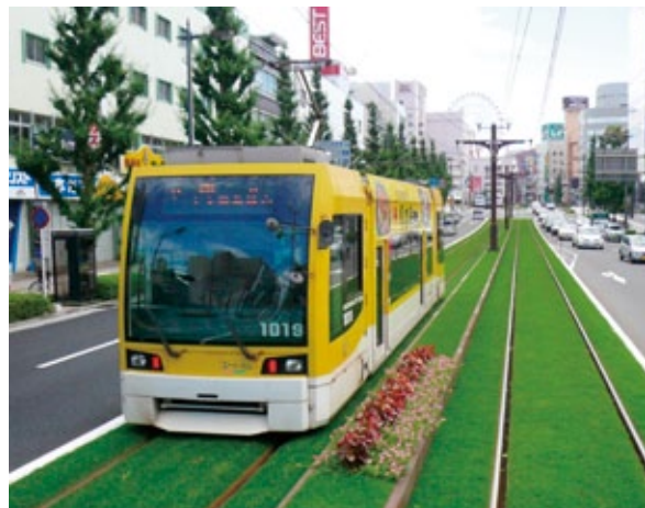
図 16 シラスを用いた緑化基盤による軌道敷緑化
