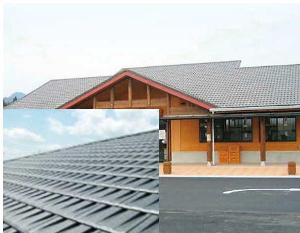
図 14 シラス大判瓦を用いた屋根（左下：拡大写真）
